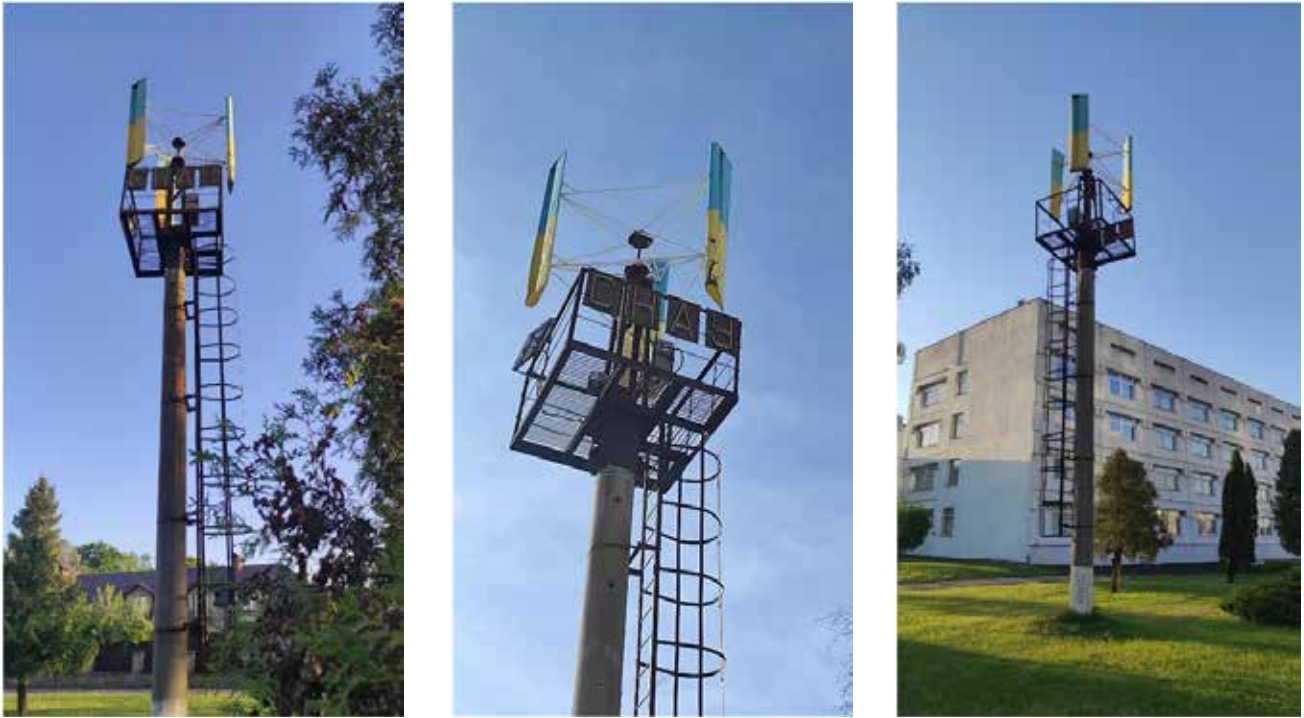
Рис. 6. Створена ВЕУ з лопатями з «карманом» і щілиною
